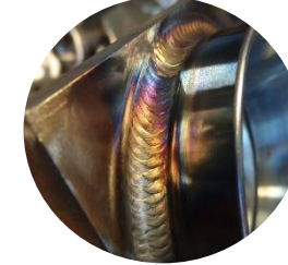
Контроль сварных швов
